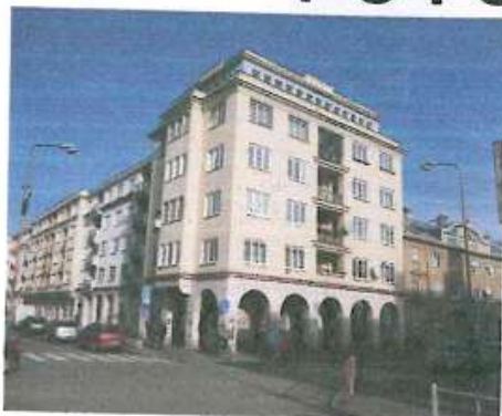
Dom súp. č. 2137 - pohľad JZ na koncovú päťposchodovú časť
