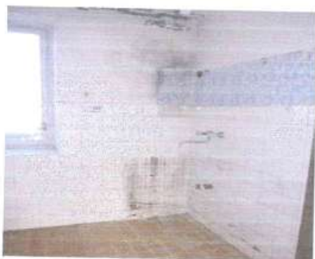
Nebytový priestor - kuchynka v pravej časti - miestnosť č. 10
