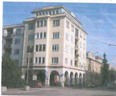
Dom súp. č. 2137 - pohľad JZZ na koncovú päťposchodovú časť
