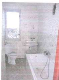
Nebytový priestor - kúpeľňa s WC v ľavej časti - miestnosť č. 12
