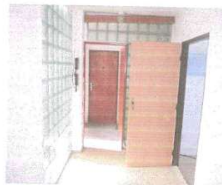
Nebytový priestor - chodba v pravej časti - miestnosť č. 5
