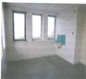
Nebytový priestor - izba v ľavej časti - miestnosť č. 3
